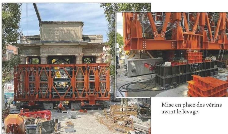
Mise en place des vérins avant le levage.
